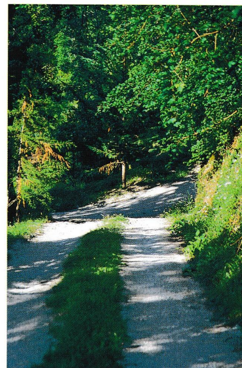
Fahrkönnen statt Fahr- vergnügen – unbefestigte Zufahrt zu einem Kastell
