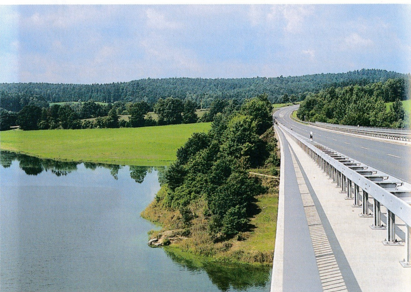
Hoch über dem Wasser spannt sich die moderne Brücke über die Talsperre Eixendorf ; an ihrem Ostufer wurde ein Parkplatz angelegt → Route 20, Rund um Oberpfälzer- und Böhmerwald.
