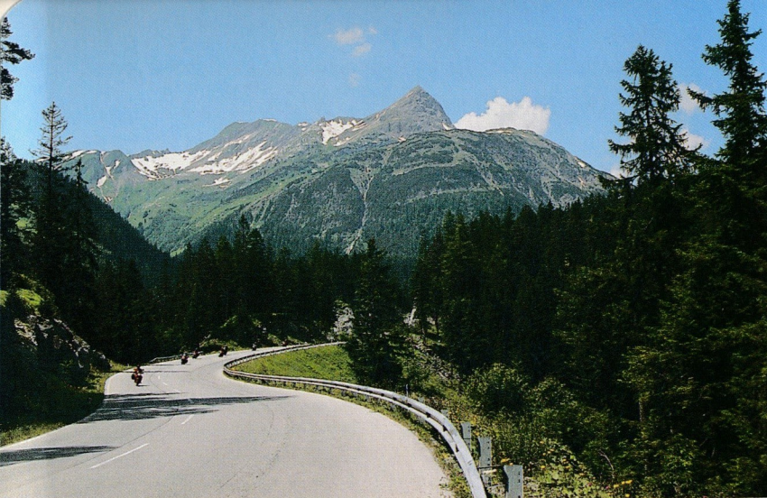
Großzügig ausgebaut zeigen sich die Fahrbahnbreiten der B 198 im Streckenabschnitt zwischen den Lechtaler Orten Steeg und Warth → Route 5, Rund um die Allgäuer Alpen.
